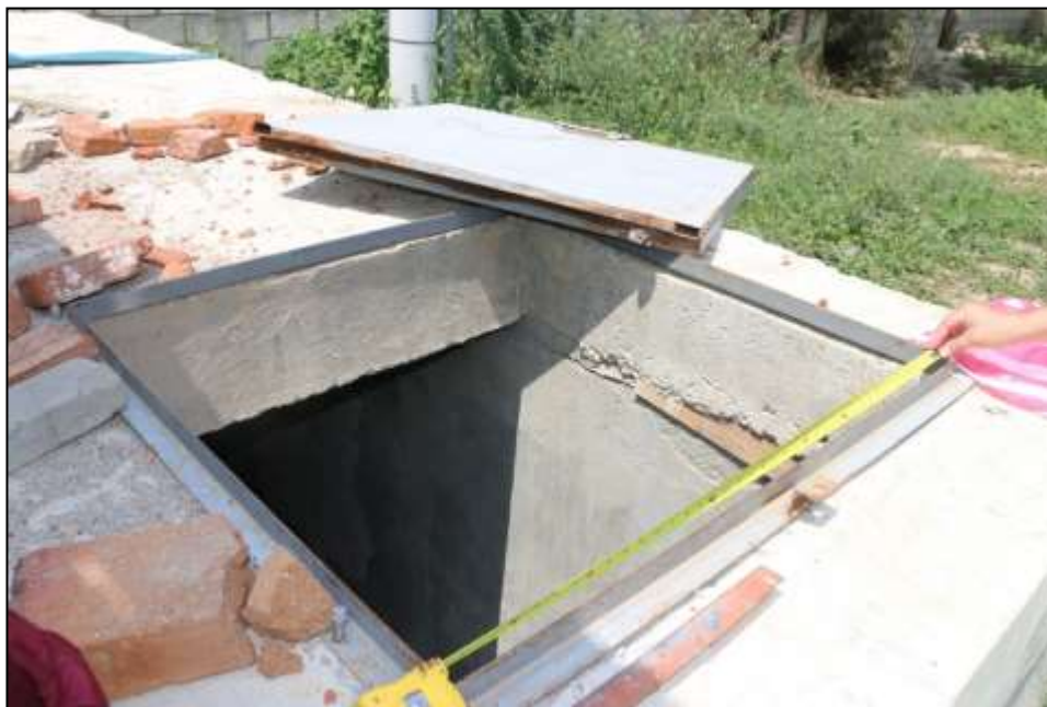
Fotografía No. 5 Detalle de la tapa de acceso al cuarto de máquinas, IED Rodrigo de Bastidas. Según medida tomada por la CGR, este accesorio tiene 1,0 m x 1,0 m (dimensiones diferentes a la especificación técnica del ítem de pago).
