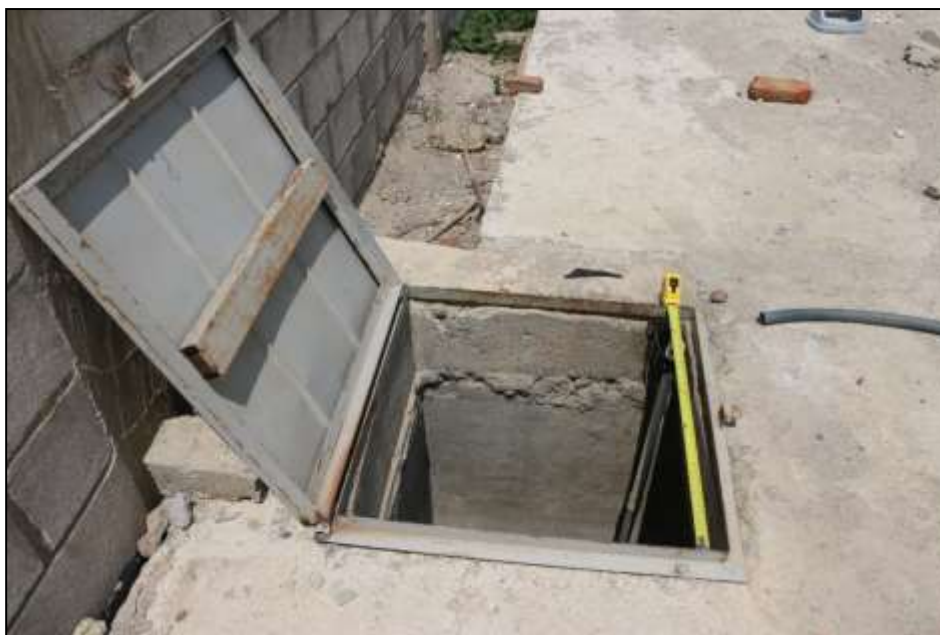
Fotografía No. 6 Detalle de la tapa de acceso al tanque de almacenamiento, IED Rodrigo de Bastidas. Según medida tomada por la CGR, este accesorio tiene 0,7 m x 0,7 m (dimensiones diferentes a la especificación técnica del ítem de pago).
