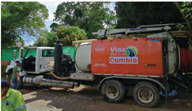
Lugar: Santa Ana Observaciones: Maquinaria operando
