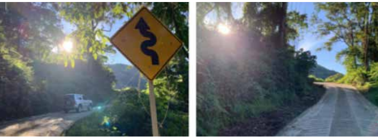
Ilustración: Fin de obra vía Minca - La Tagua
