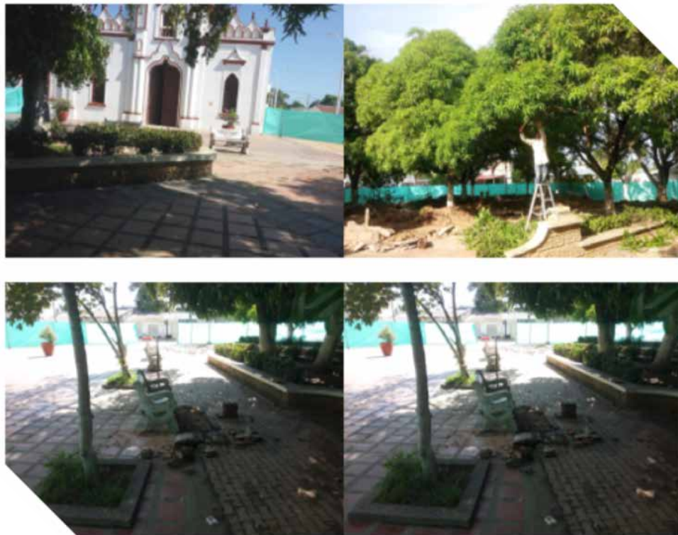
Ilustración 38. Inicio de obras Parque Simón Bolívar – Aracataca
