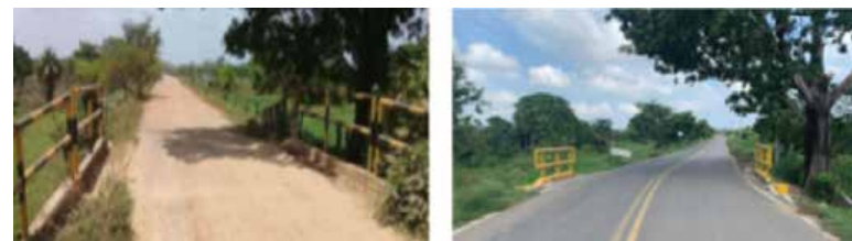
Ilustración: antes y después de las obras vía Pijiño del Carmen – La Gloria
