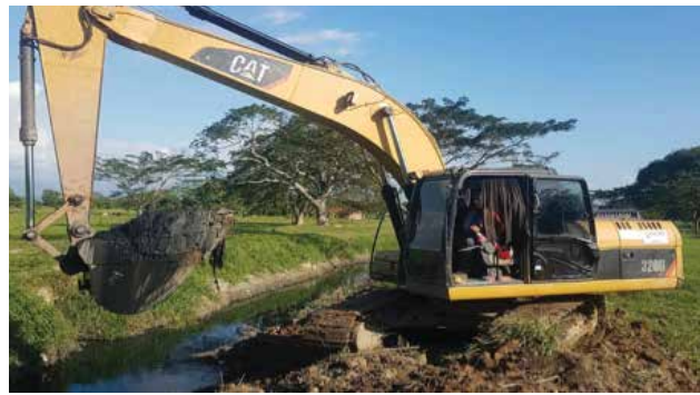
Lugar: Zona Bananera Observaciones: Maquinaria operando
