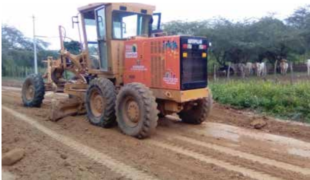
Lugar: Santa Ana Observaciones: Maquinaria operando
