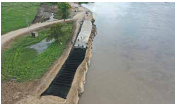
Lugar: Municipio de Salamina, vía que conduce de Salamina al Piñón obras para la protección de la orilla de la margen derecha del río Magdalena K2+400 km 2.4 Observaciones:
